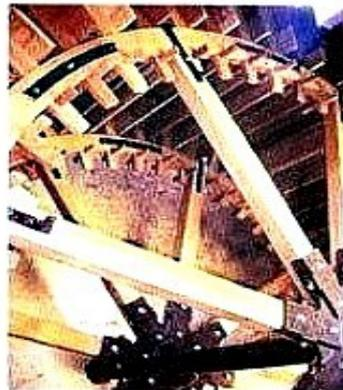
Restauration de la roue du Moulin de Fossé dans le strict respect des techniques d'assemblage par clés des jointes et des coyaux des roues du XVIII<sup>ème</sup> siècle (voir site).
