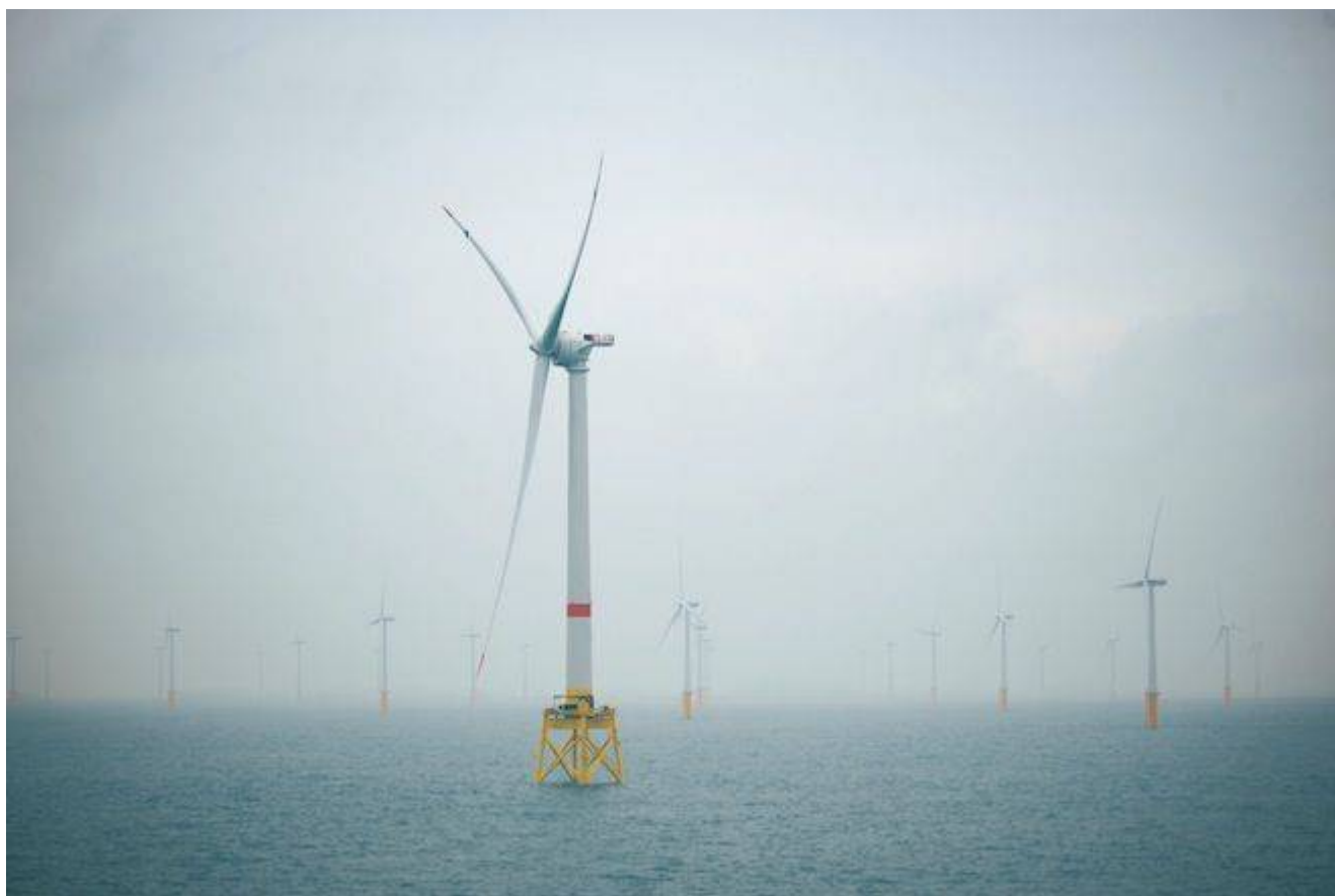
L'Haliade 150 est installée sur le champ Belwind, au large d'Ostende (DR).
