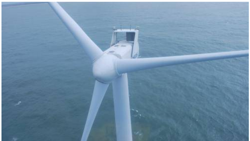
La turbine Vestas de 2 MW (MER ET MARINE - CAROLINE BRITZ)
