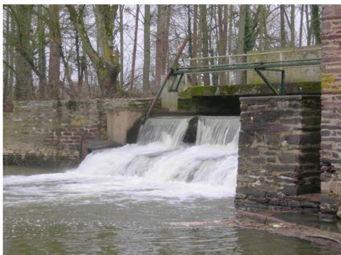
Les cinq vannes levantes à crémaillère de 1.35 m de large sont remplacées par un clapet à commande automatique de 8 m de large en 1986. Ce clapet, plus pénalisant pour les anguilles, est imposé par la DDA, le pompage d'eau potable aménagé par la Collectivité Eau du Bassin Rennais à la Ville Chevron ayant besoin de la hauteur d'eau fixée par le seuil du moulin.
