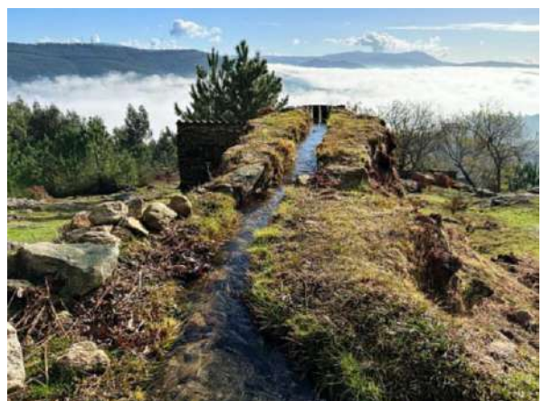
Un réseau d'aqueducs canalise vers les moulins les eaux de la montagne.
